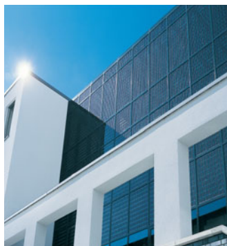
Instalacja na elewacji
